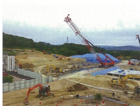
平成27年6月現在の工事状況
