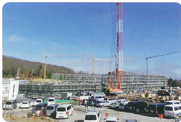
新病院の建設工事風景
